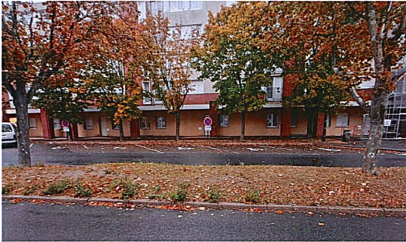
Places de stationnement réservées aux personnes à mobilité réduite (PMR)
